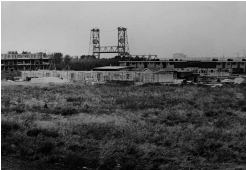
Nieuwbouwwijk in Hoogvliet in aanbouw (archief Rotterdam)
